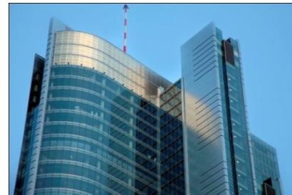
公共建筑—宾馆、医院、机场
